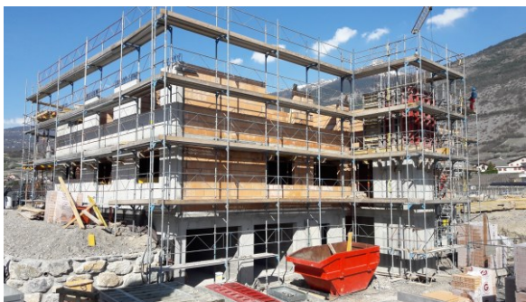
Ansicht Rohbau Haus 1
