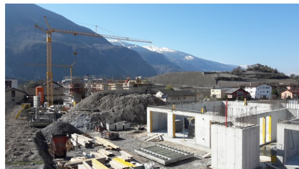
Ansicht Rohbau Haus 1 und 2
